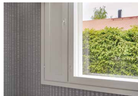
Avattava ikkuna tuuletusluukulla.
